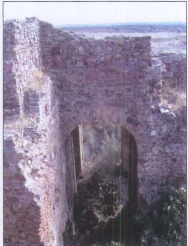
SQ001.- Hueco del pozo y tolva de la estructura del Pozo Don Raimundo.
