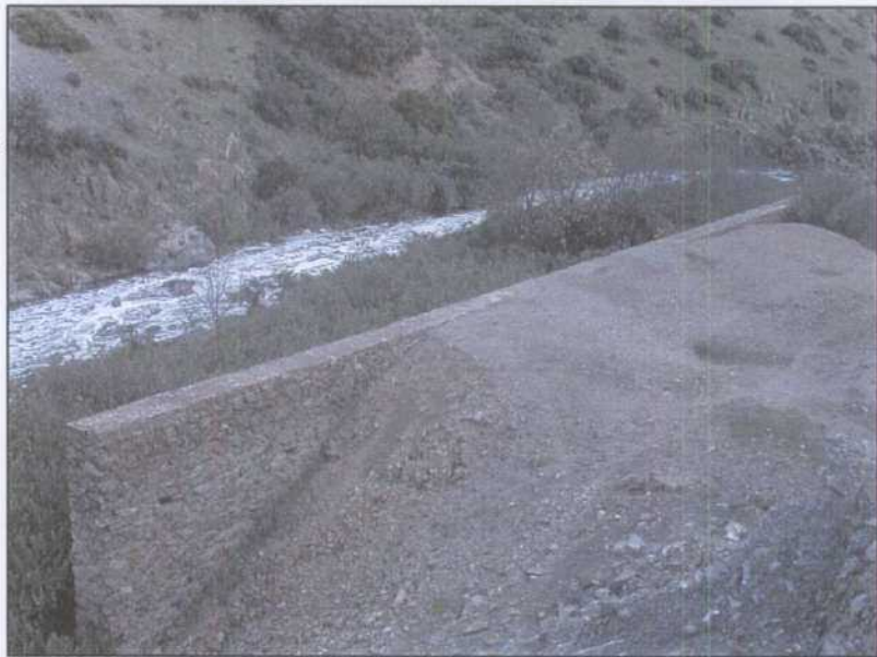
GY007.- Muro de contención de la escombrera y lavadero de mineral.
