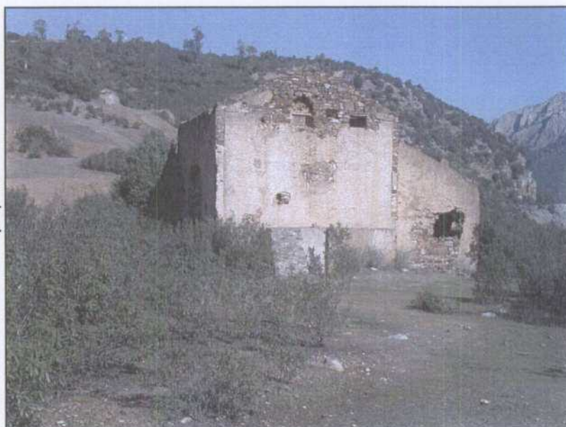
PT018.- Caseta del transformador eléctrico para la alimentación del lavadero de flotación.
