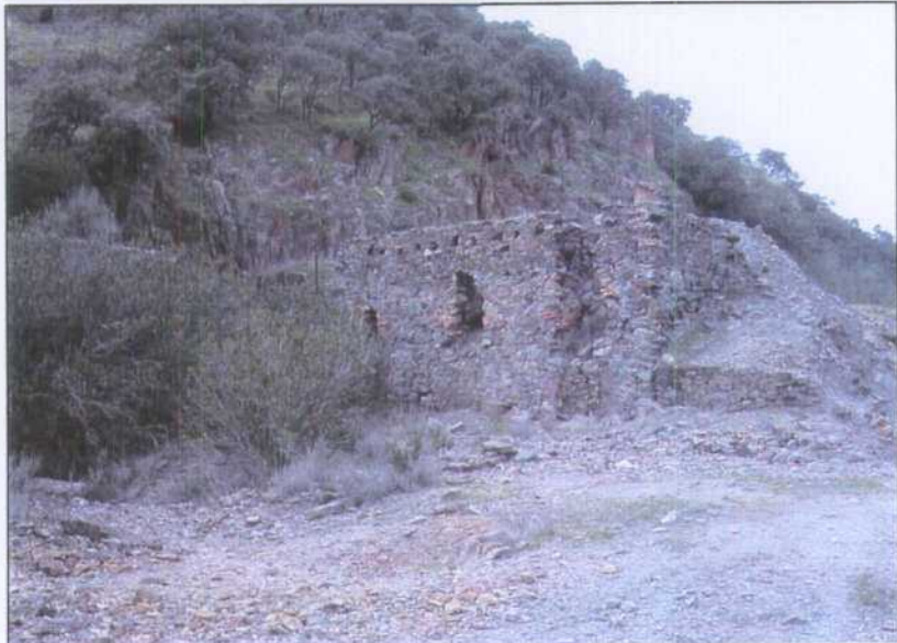
GY003.- Tolvas de descarga del mineral para su tratamiento en el lavadero.
