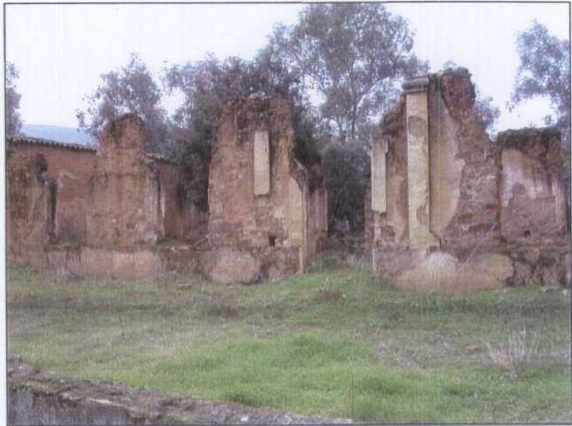
NR006.- Ruinas de edificios de servicios del poblado minero.
