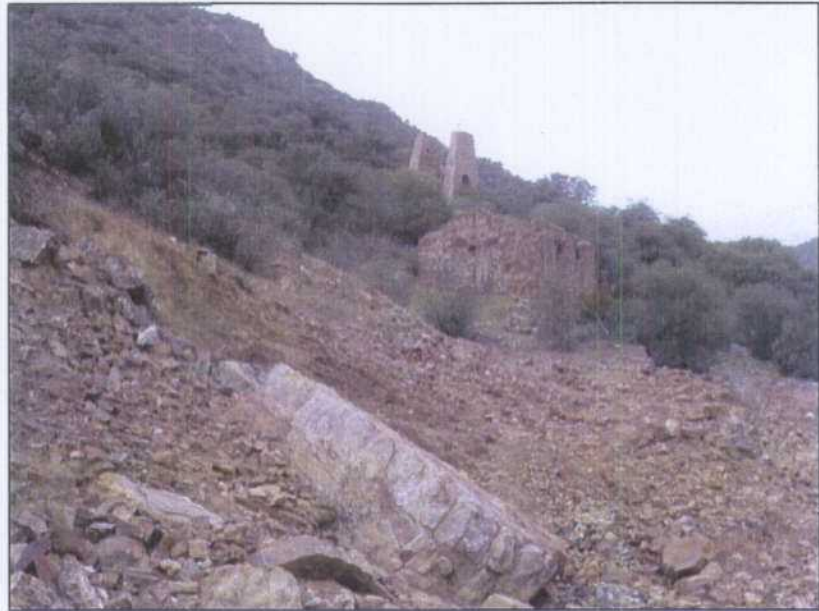
PT004.- Edificio auxiliar de la mina Carmen.
