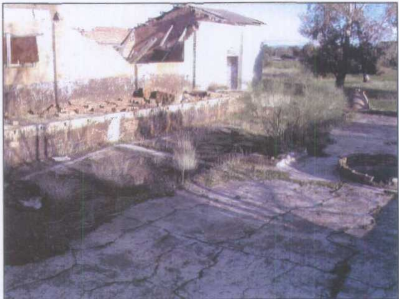
CP009- Lavadero de flotación. Era de secado de concentra- dos.
