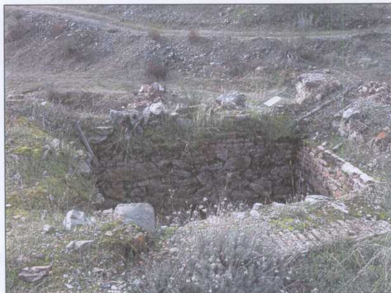
RN001.- Emboquille del pozo maestro de la mina Rica Nueva.
