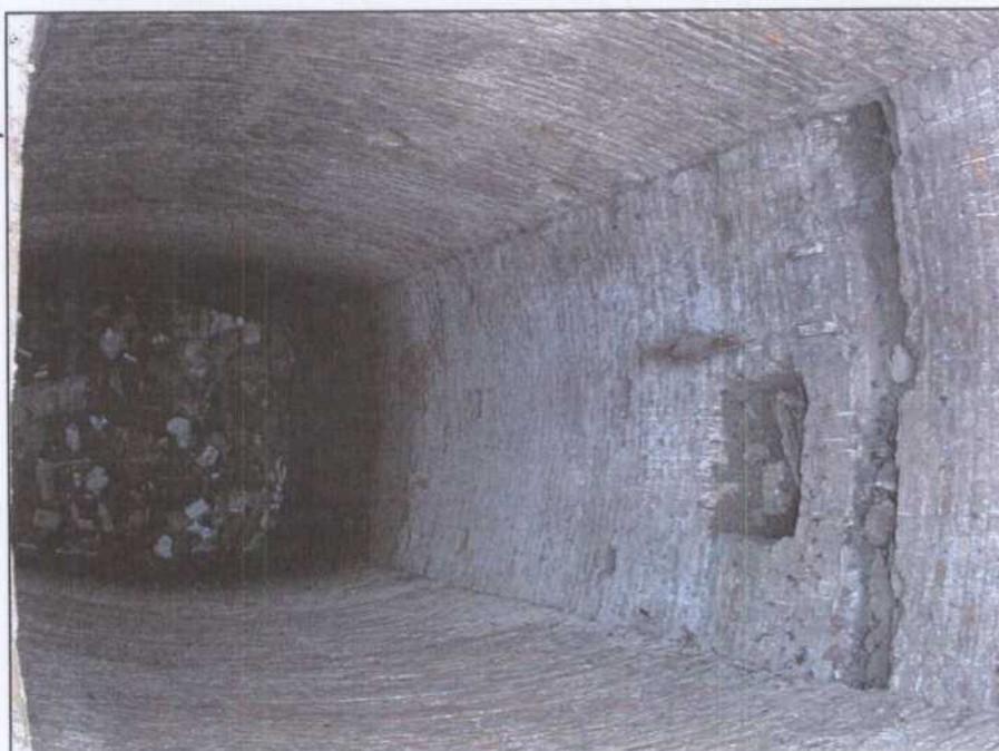
VG006.- Pozo Buen Pensamiento. Vista frontal.
