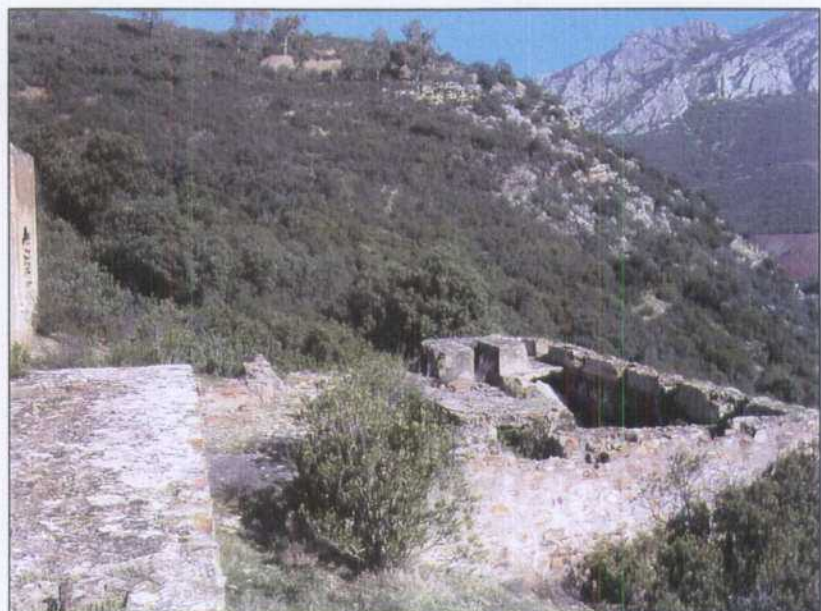
PT013.- Restos de la casa de máquinas del pozo de la mina Santa Isabel.
