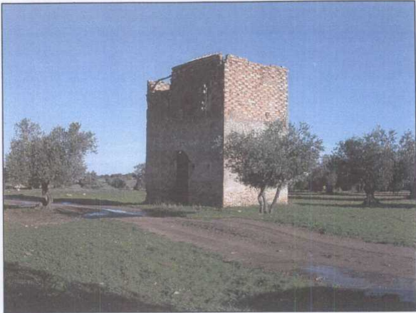
CP002.- Caseta de transformador eléctrico.
