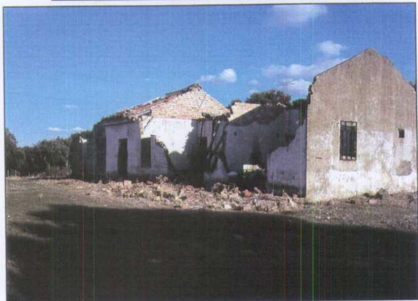
VC006.- Casas de la mina San Pablo.
