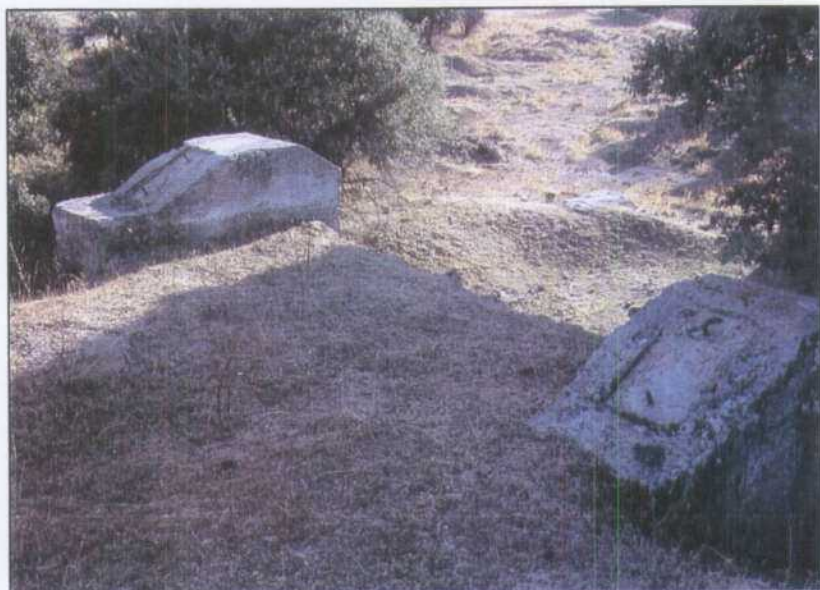
VC001.- Zapatas de apoyo de los pies delanteros del castillete metálico del pozo San Juan.
