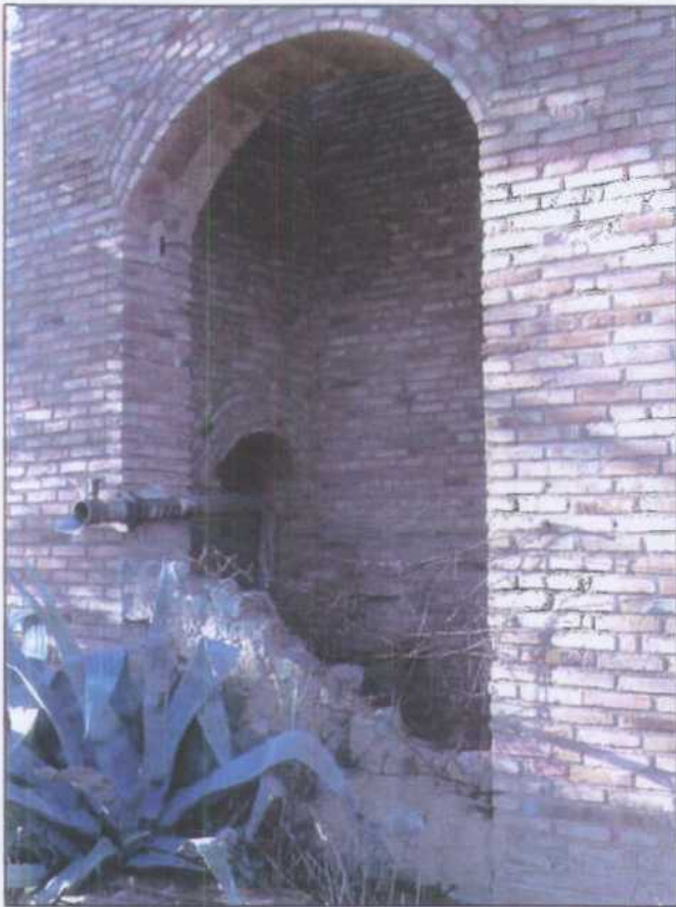
CP011- Embarque frontal del pozo nuevo de poniente.
