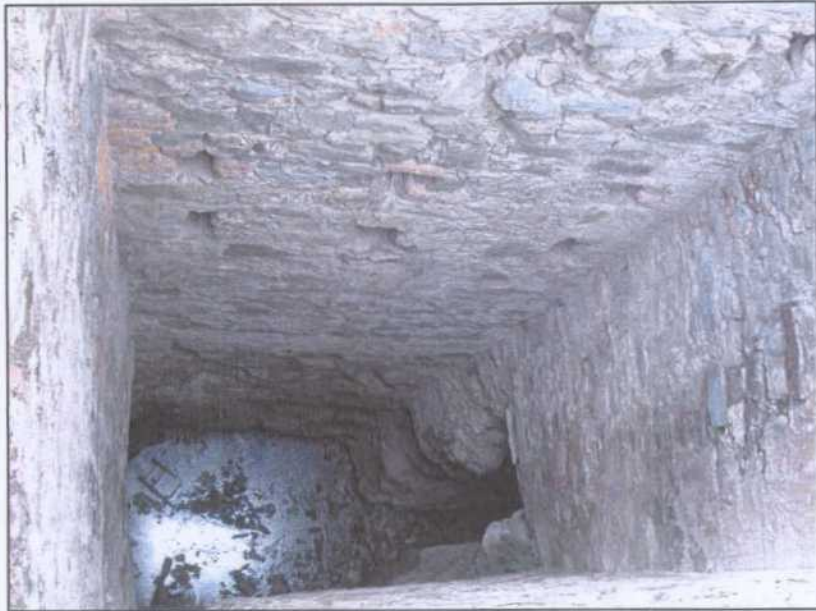
RN001.- Caña del pozo maestro de la mina Rica Nueva.
