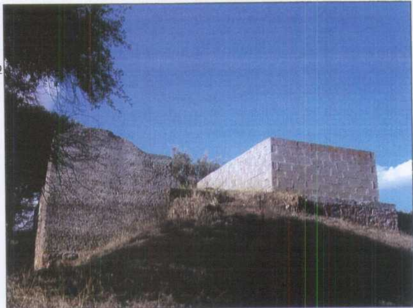
VC001.- Pozo San Juan, con el emboquille protegido por un brocal de bloques de cemento.
