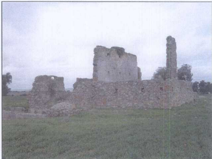
VG004.- Restos de la casa de máquinas del pozo Lolita. Por delante a la izquierda se ve el brocal de un pozo auxiliar y el depósito de agua del bombeo de la mina.
