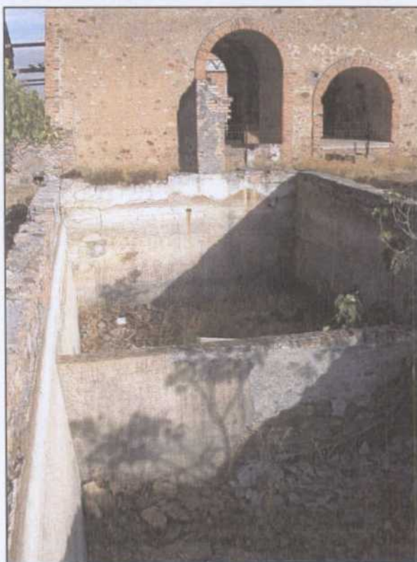
VZ004.- Depósitos de acumulación del agua del bombeo de la mina.
