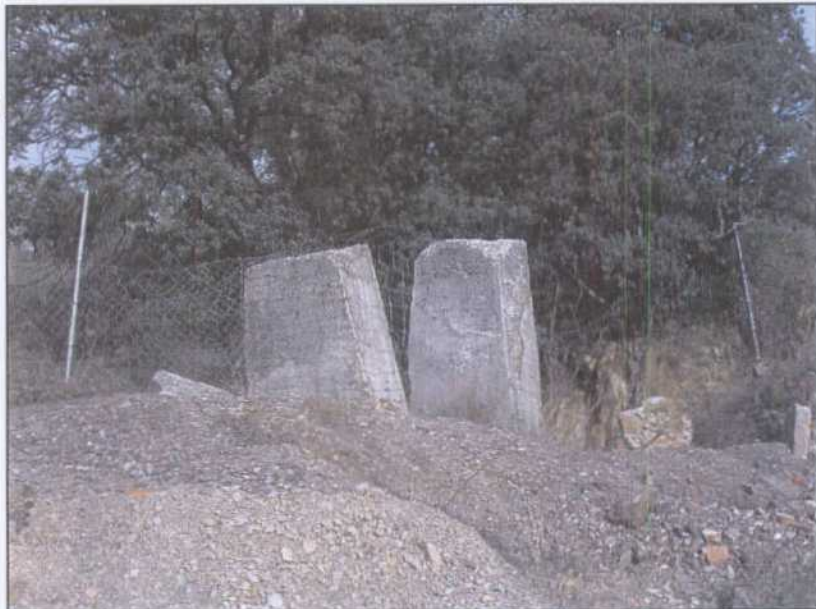
RN002.- Los escasos restos del lavadero. Detrás hay una labor sobre filón.
