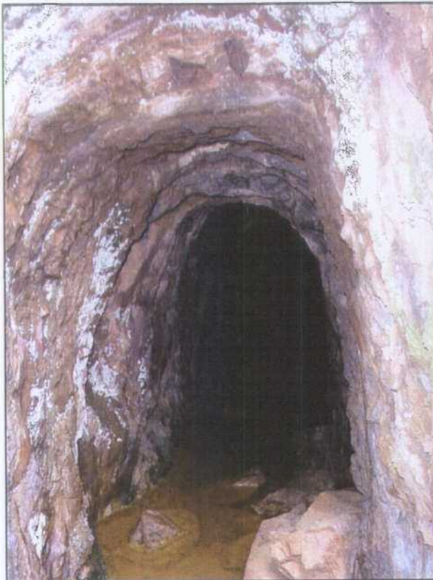
3R001.- Socavón romano de la mina 3er Robledillo. Galería.
