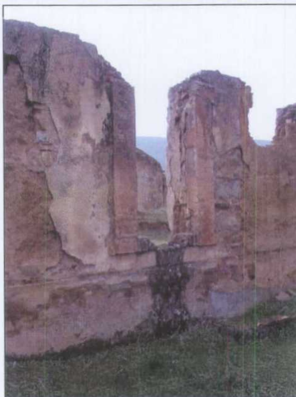
NR005.- Ruinas de viviendas de empleados cualificados. Ventanal.
