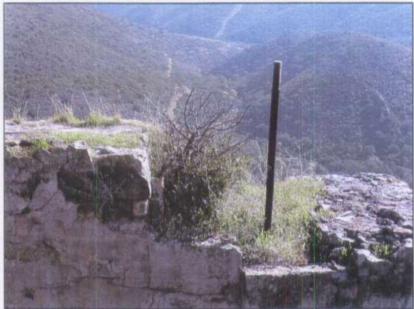
PT013.- Espárrago de sujeción del castillete metálico que tenía el pozo de la mina Santa Isabel.
