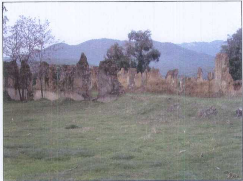
NR007.- Ruinas de edificios de almacenes y servicios.
