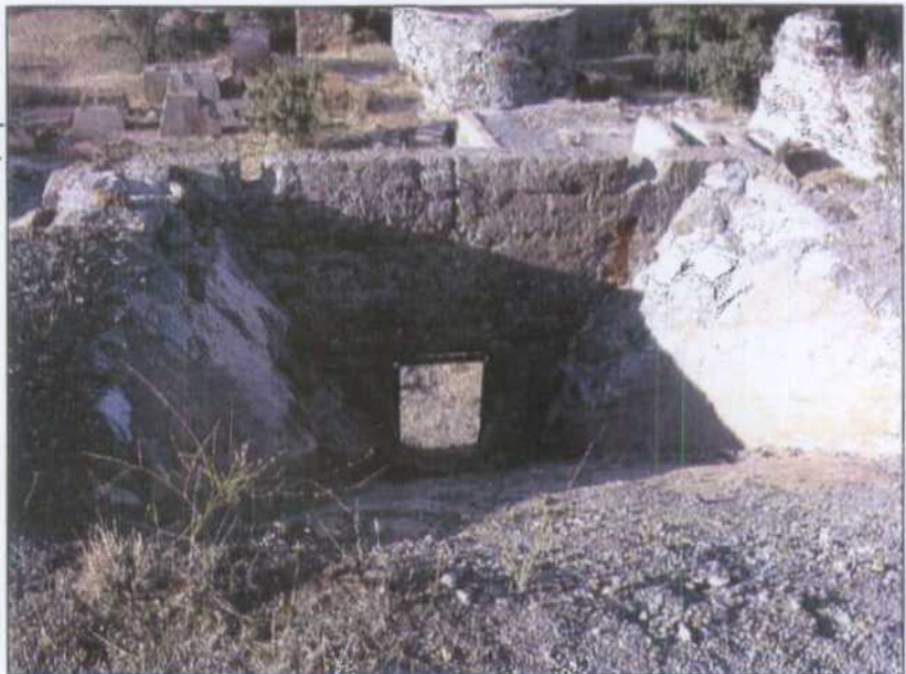
VC007.- Tolva de volcado de minerales del pozo San Pablo, para la alimentación de la planta de preparación.
