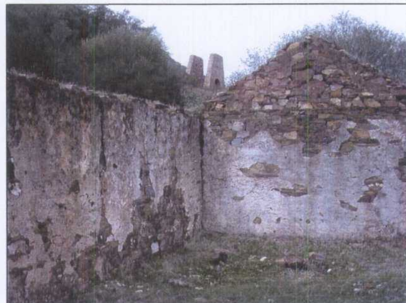
PT004.- Edificio auxiliar de la mina Carmen. Interior
