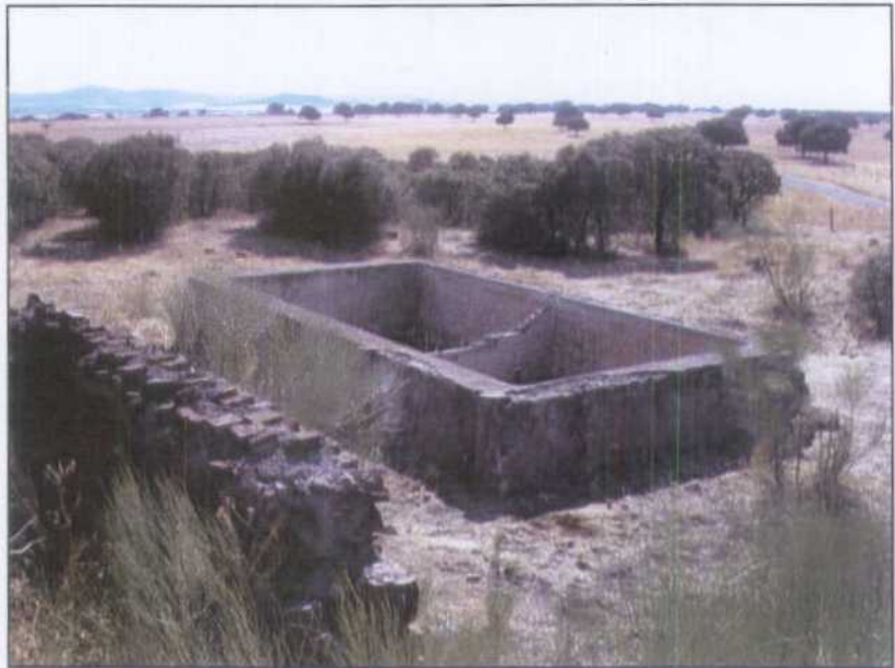
SQ014.- Depósito de acumulación de agua del bombeo de la mina.
