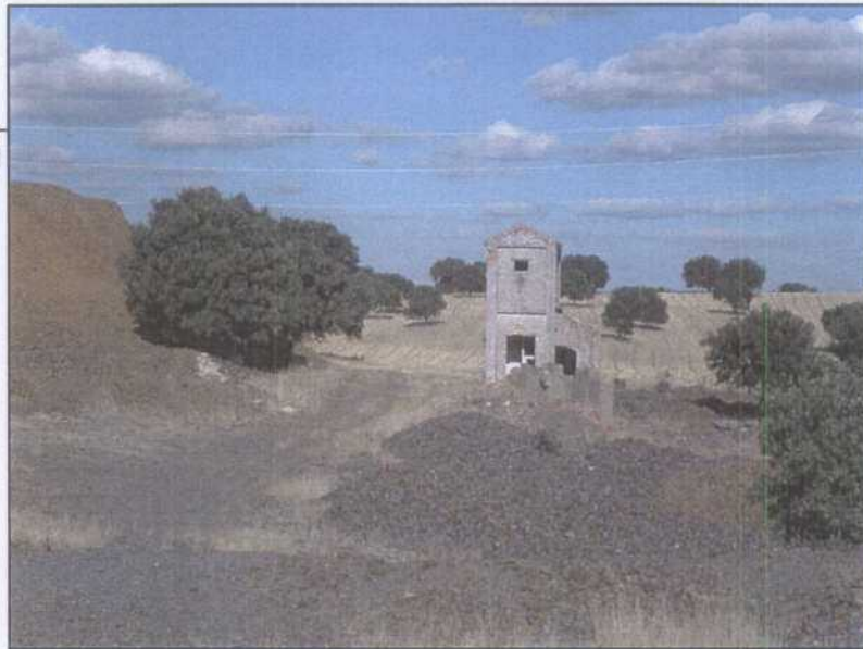
VG008.- Caseta del transformador eléctrico de suministro al lavadero de flotación
