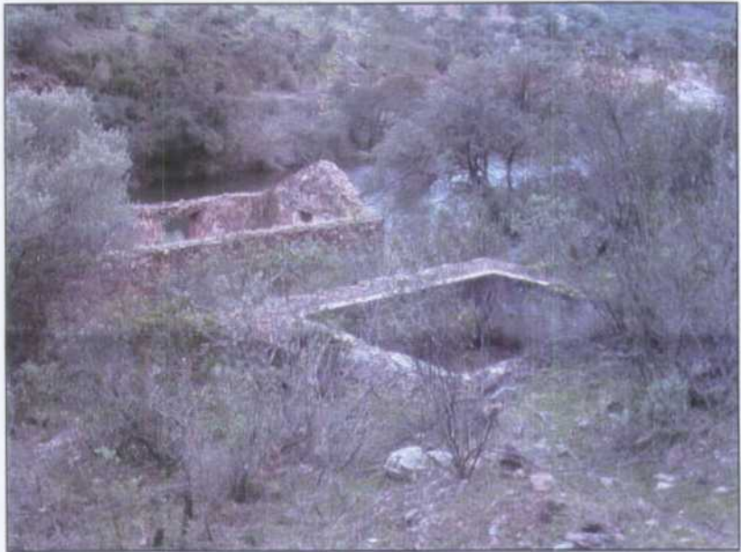
PT005.- Depósito de agua para servicio del edificio auxiliar de la mina Carmen.
