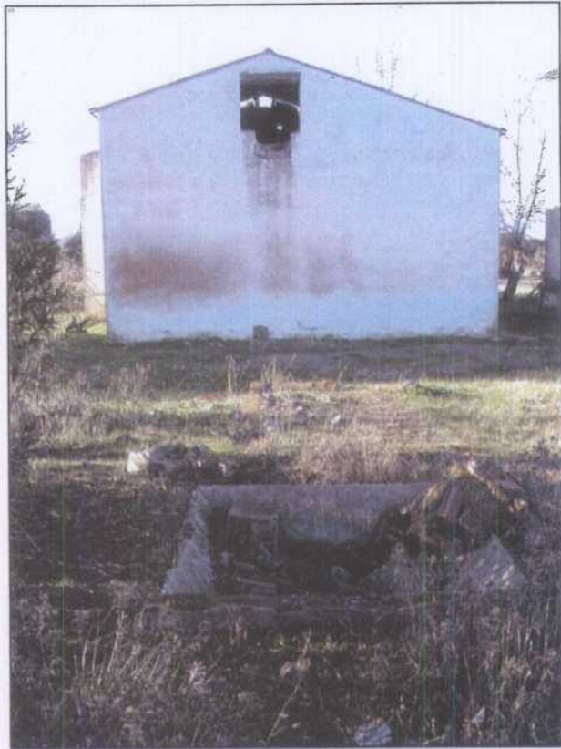
CP009- La entrada de los minerales se realizaba mediante una cinta transportadora. En la imagen se ve el punto de carga de la cinta y la entrada superior de un silo de almacenaje del todo-uno.
