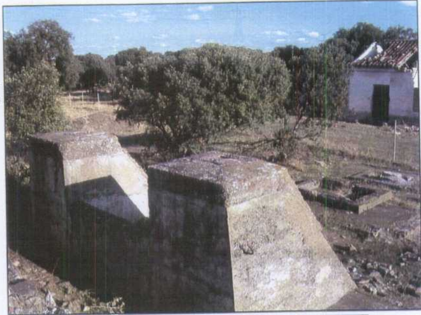
VC005.- Apoyos de los pies delanteros del castillete del pozo San Pablo.
