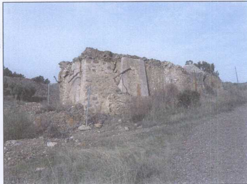
RN001.- Estructura de mampostería del pozo maestro de la mina Rica Nueva.
