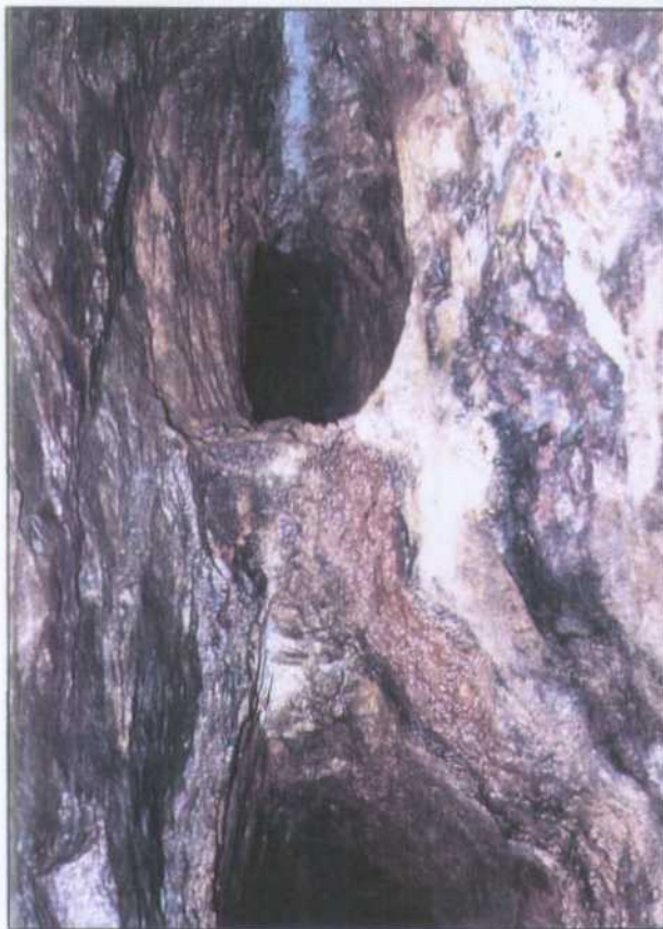
CP005.- Socavón de Los Murciélagos. Galería de finales del siglo XIX con una galería romana sobre el techo.
