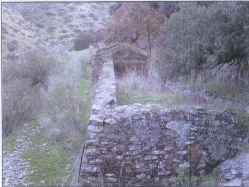
GY002.- Depósito de acumulación del agua del bombeo de la mina.
