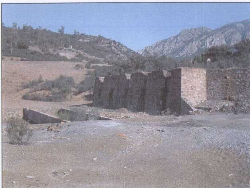
PT017.- Tolvas para la carga de rechazo de material triturado de la desbastadora del lavadero.
