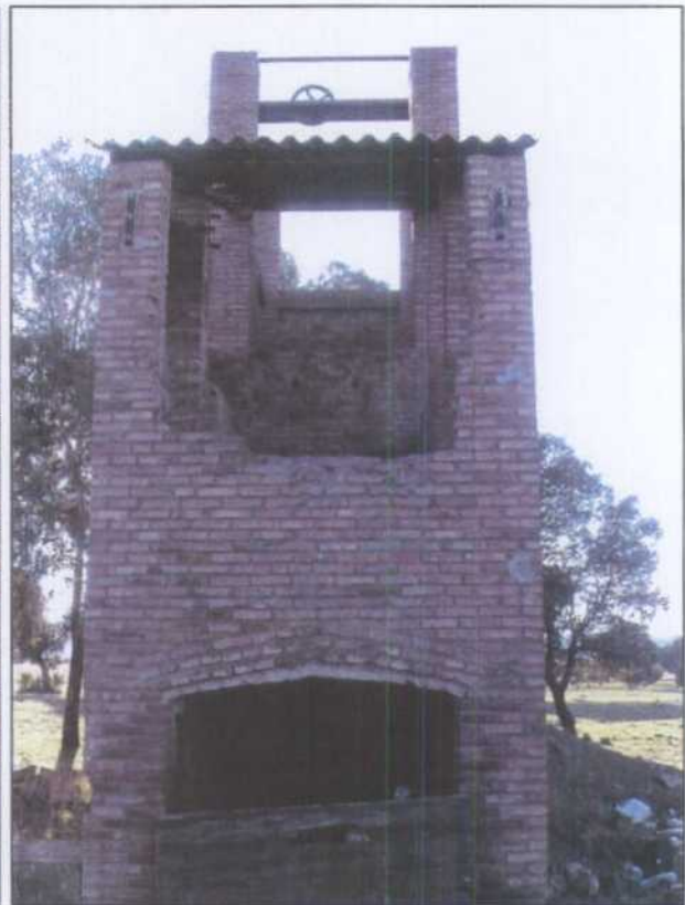
CP011- Pozo nuevo de poniente. Criba y tolva de descarga de minerales.
