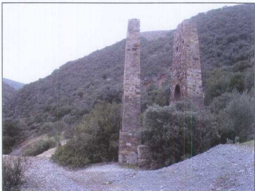
PT003.- Cabria de mampostería del pozo de la mina Carmen. Vista trasera.
