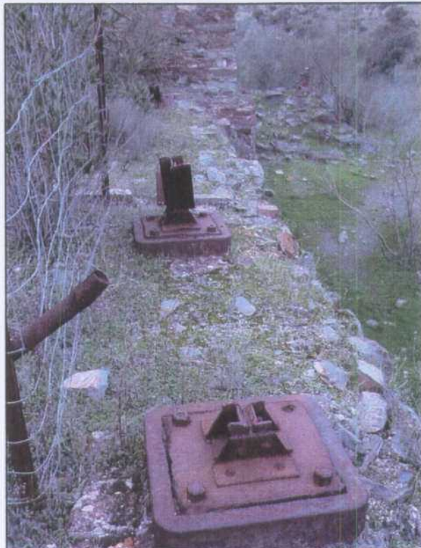
GY001.- Zapatas de asiento de los pies del pozo San Cándido.
