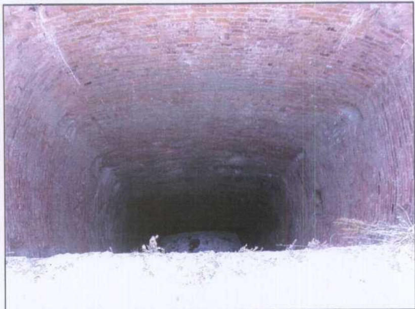
VC001.- Caña del pozo San Juan.
