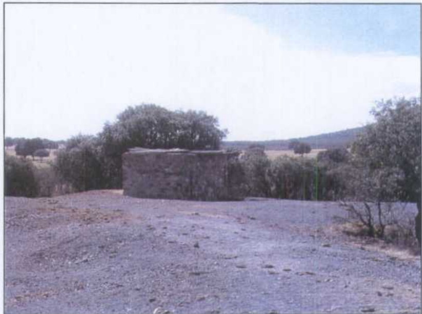
SQ015.- Emboquille del pozo auxiliar de Armando por donde se introducían los rechazos del lavadero para rellenos de la explotación.
