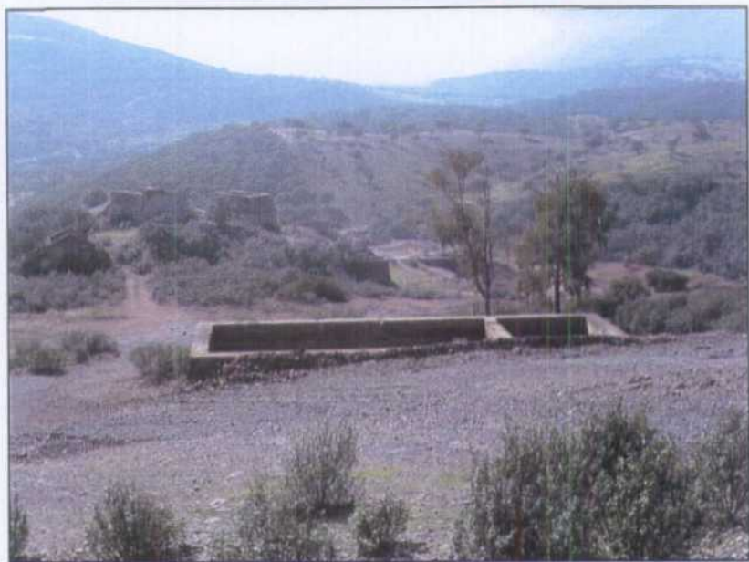
PT014.- Depósito de acumulación de agua del bombeo del pozo de la mina Santa Isabel.
