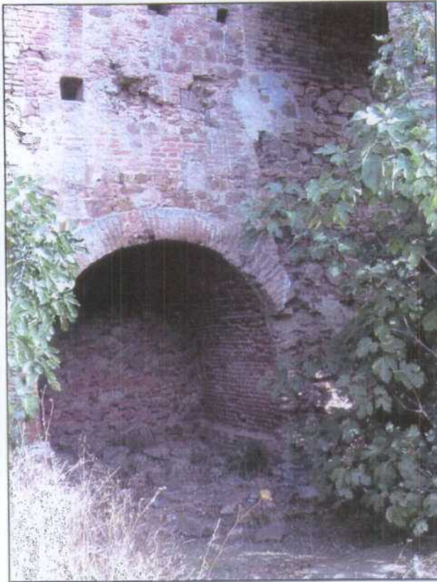
SQ001.- Embarque del pozo Don Raimundo a nivel del suelo. El emboquille del pozo está tapado por una losa de hormigón.
