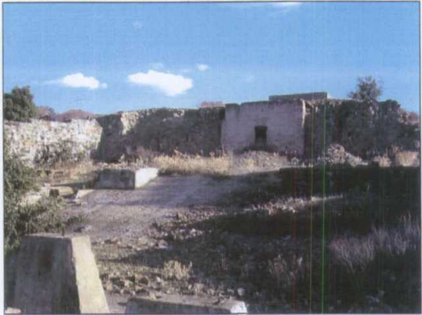
VC007.- Restos de la planta de preparación de minerales de la mina San Pablo.
