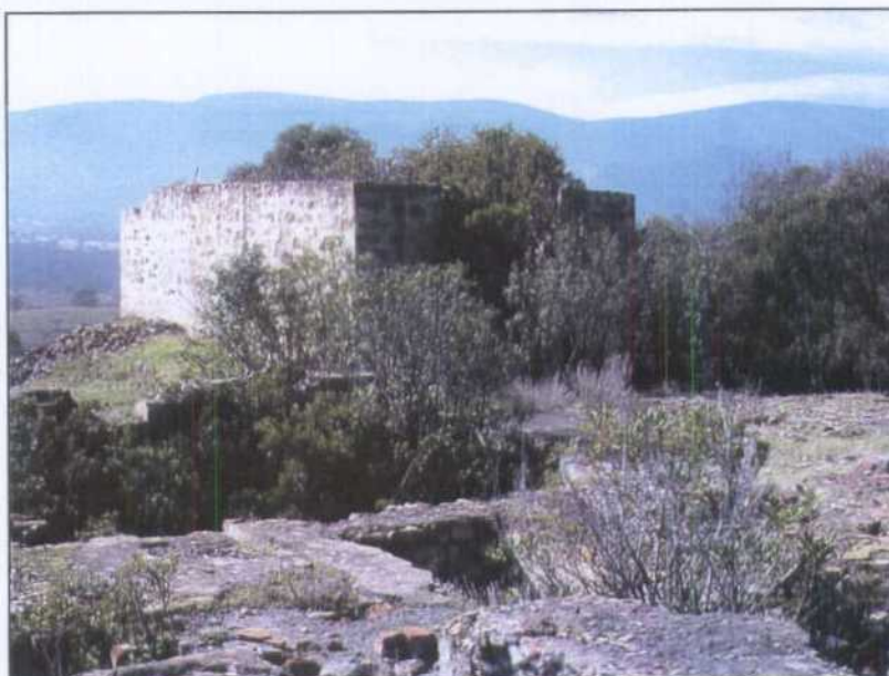
PT013.- Estructura del pozo de la mina Santa Isabel y restos de la casa de máquinas del pozo.
