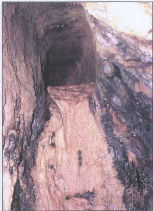
CP005.- Socavón de Los Murciélagos. Galería de reconocimiento siguiendo una galería romana.
