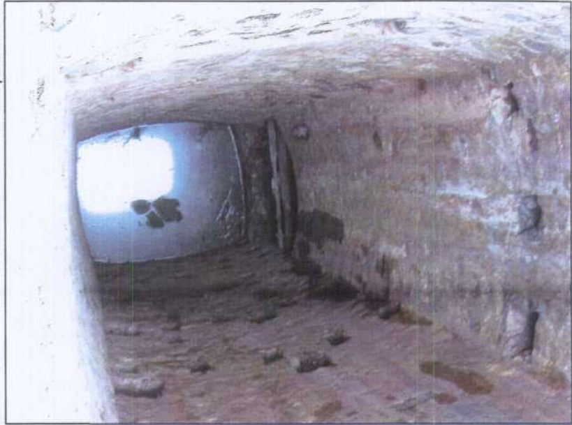
PT003.- Caña del pozo de la mina Carmen.
