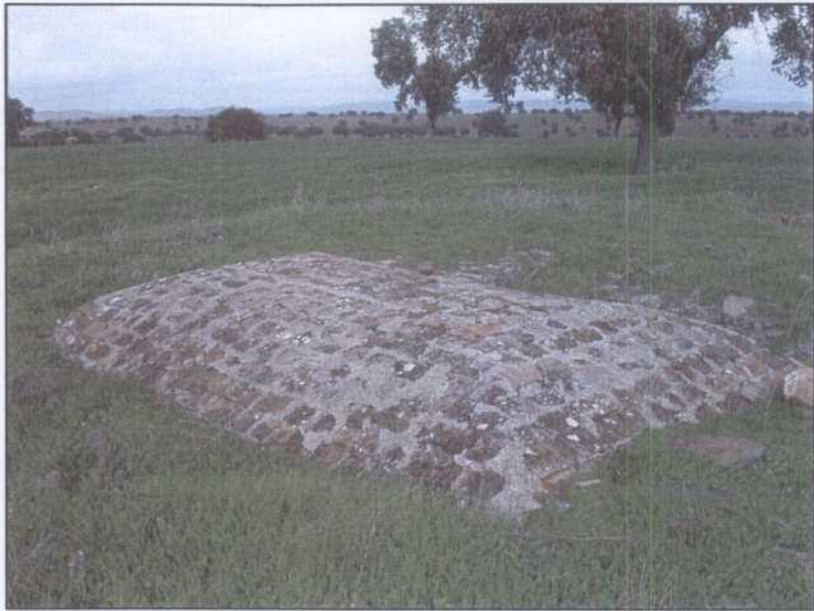
VG004.- Cubierta de ladrillo del pozo Lolita.
