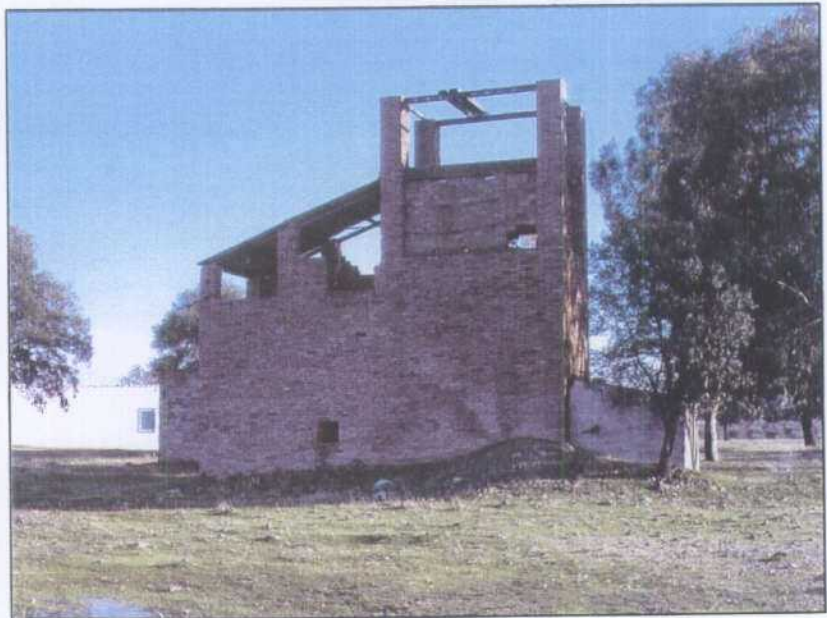
CP011- Pozo nuevo de poniente. Vista trasera.
