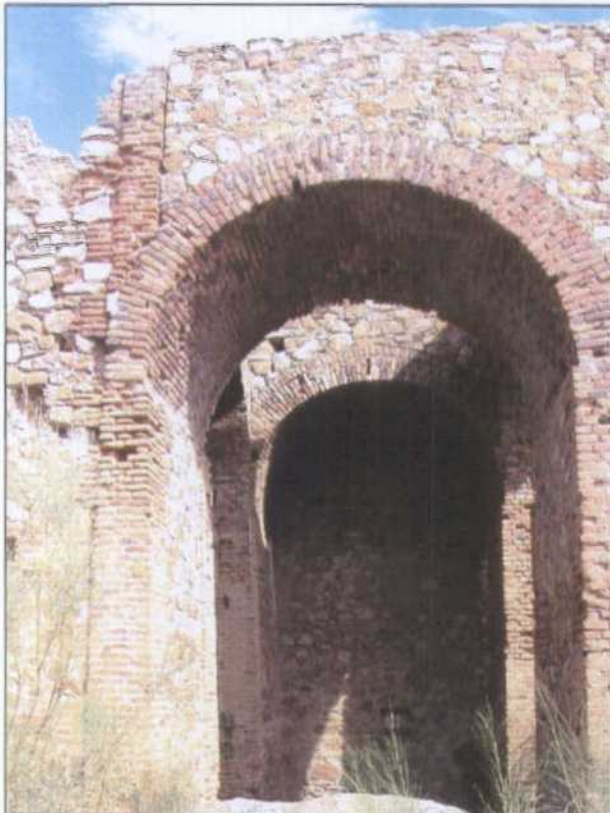
SQ001.- Tolva de la estructura del Pozo Don Raimundo.
