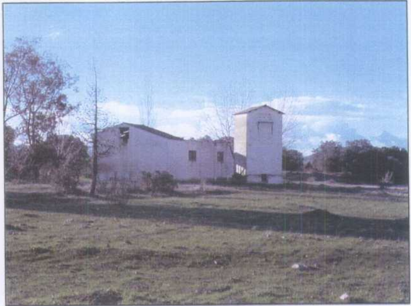
CP009- Lavadero de flotación. Vista trasera con el transformador eléctrico a un lado.
